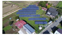
FSPS飯山市常盤発電所 運転開始年月日：平成29年8月 出力：130.0 kW 年間CO2削減量：約109.2 t
